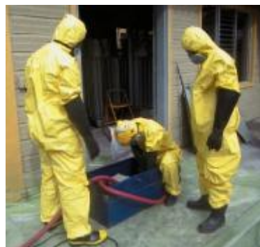
DRENAJE ADECUADO DE CLASE ONU 9 LÍQUIDOS (UN2315)
