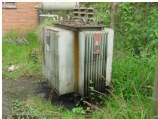
EJEMPLO DE ALMACENAMIENTO TIPO 1: BIFENILOS POLICLORADOS ABANDONADOS Y CON FUGAS
